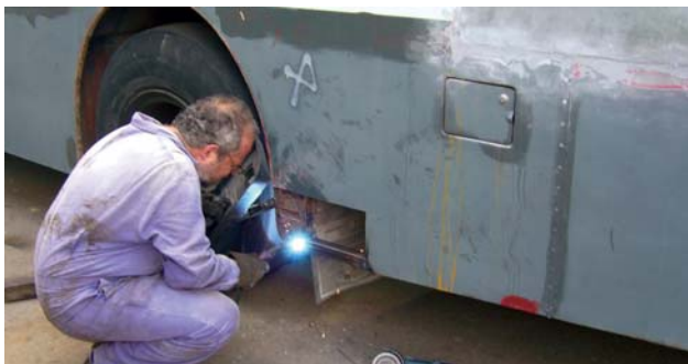
A dalt, el 25 en ple procés d'arranjament de xapa (FOTO: Marcel Estadella). Sota d'aquestes línies, el nostre president fent tasques de soldador per a la reparació (FOTO: S&S Bros.)
